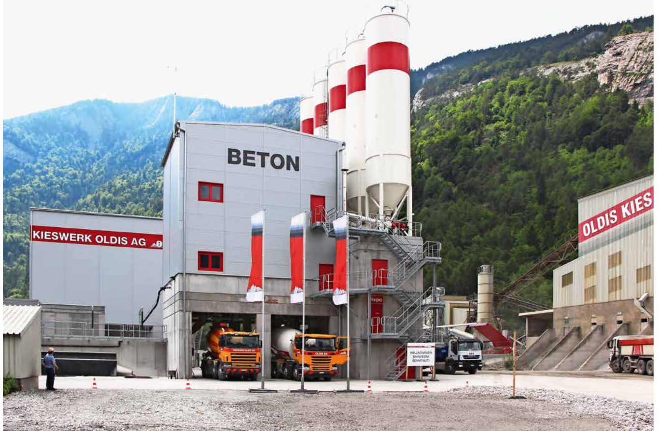
Das für die Kieswerke Oldis AG in Haldenstein bei Chur erstellte neue Betonwerk konnte nach einer Bau- und Montagezeit von bloss elf Monaten Ende Januar seinen Betrieb aufnehmen.
