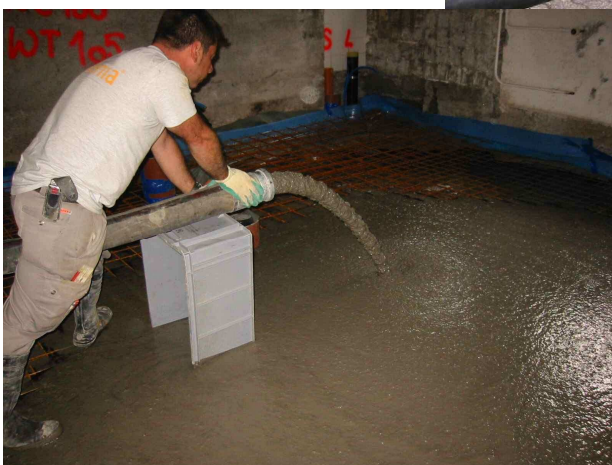
Betonieren eines neuen Kellerbodens mit SCC-Beton
